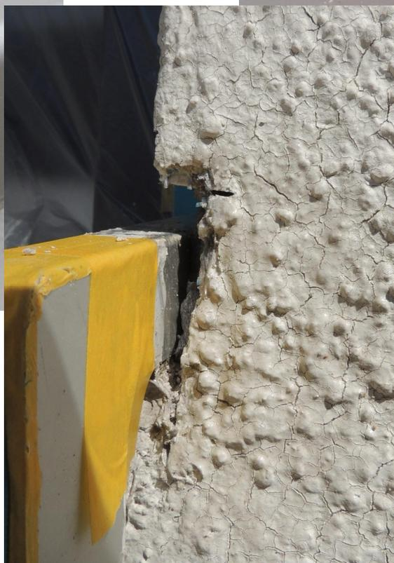
Schadensfall aufgrund undichter Anschlüsse an der Fensteranlage selbst:
